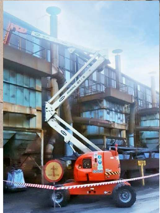
Območja za delo z dvižno košaro v SIJ Metalu Ravne ustrezno označijo in zavarujejo.
