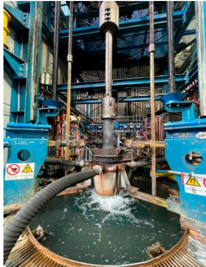
33110 je bila številka valja, ki se je zadnji kalil na starem BIKS-u. Že naslednje jutro so se začela dela na novem BIKS-u, in sicer najprej z demontažo obstoječe opreme.
