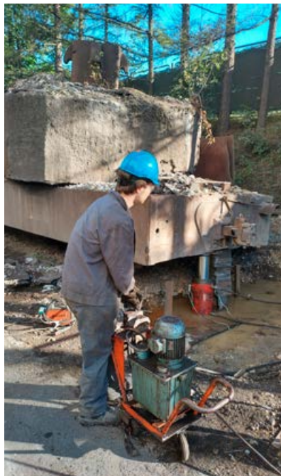
Dvigovanje iztirjenega dela livnega vagona s 'svinjo' s 300-tonskim hidravličnim cilindrom
