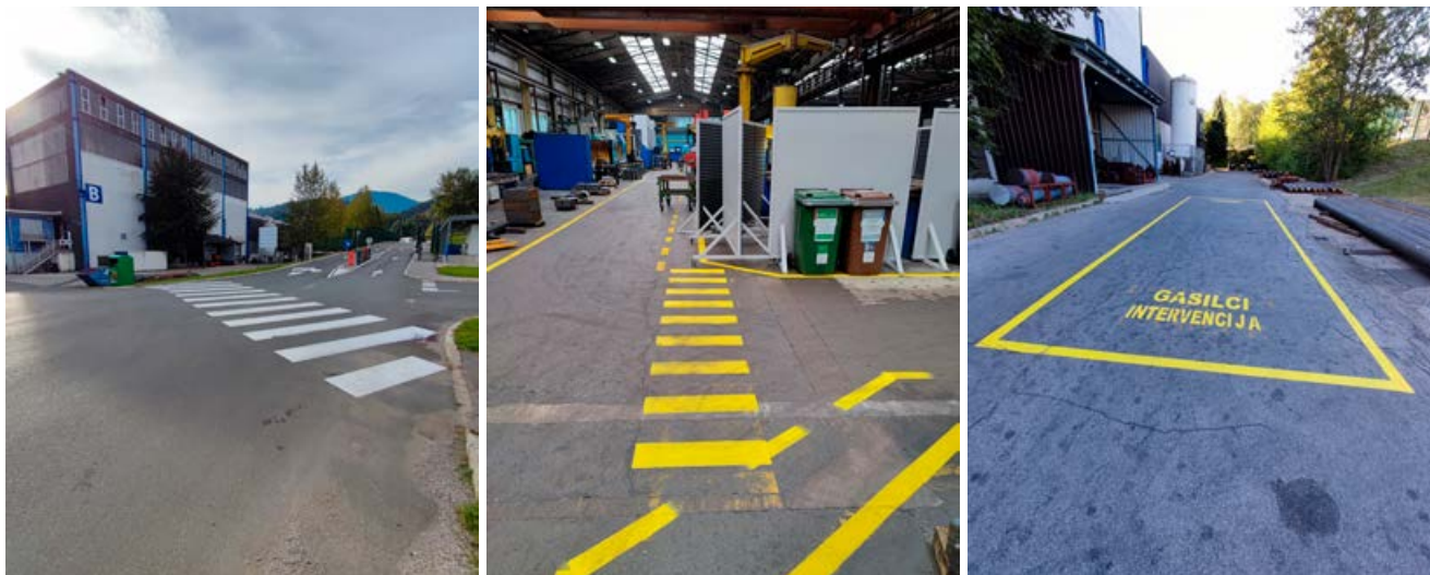
V SIJ Ravne Systems smo obnovili talne označbe (površine za intervencijska vozila, transportne poti v proizvodnji) in na kritičnih mestih zarisali tudi nove (prehodi za pešce, na prevzemu in izdaji materiala v Logistiki).
