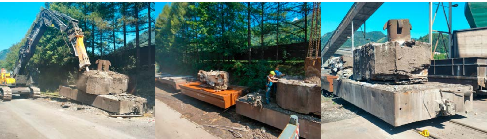
Sledila sta razdvajanje 'svinje' s hidravličnim rušilnim kladivom ...
